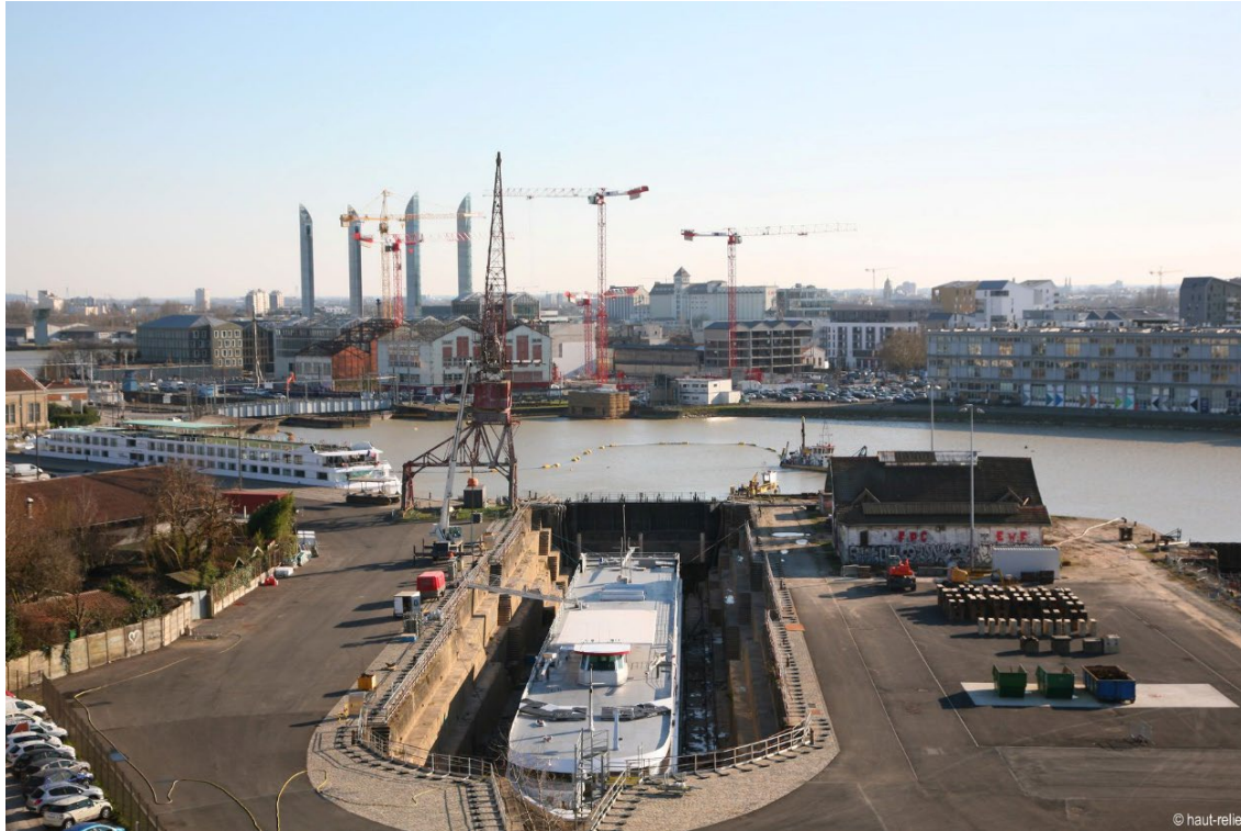
Forme de radoub # 1- Bordeaux
